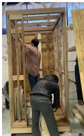
写真1 ブース組立の様子
